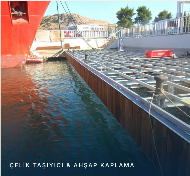
GALVANİZ ÇELİK ALT KONSTRÜKSİYON
